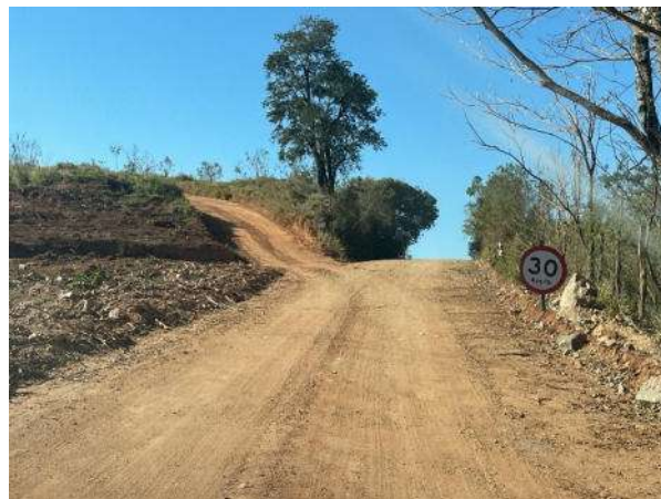
Foto 68 - Via monitorada e placa de sinalização de velocidade. (Data: 26/10/2022).
