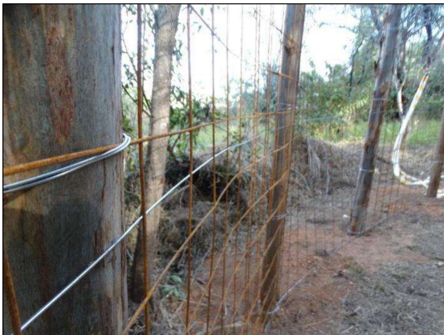
Foto 4.3-4: reforço das telas de aço com fios de arame liso (ovalado).
