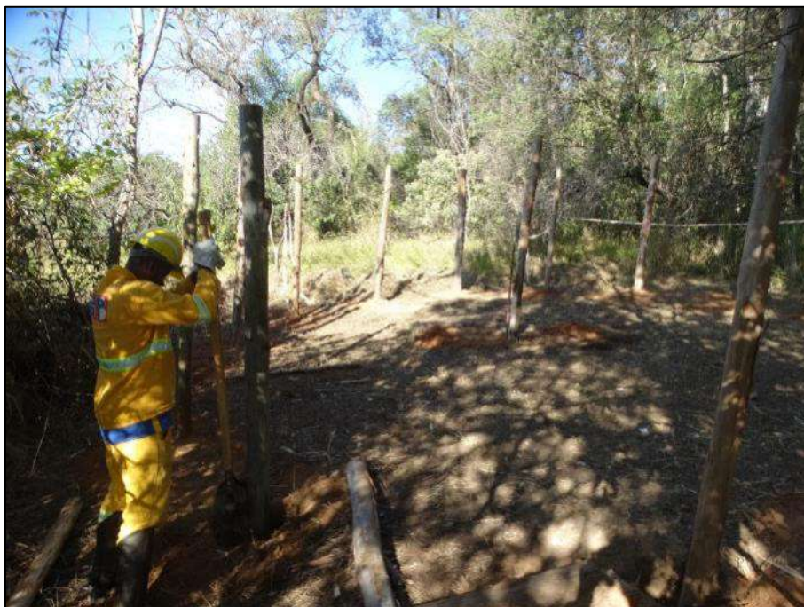
Foto 4.3-2: Fixação dos pontaletes de eucalipto.
