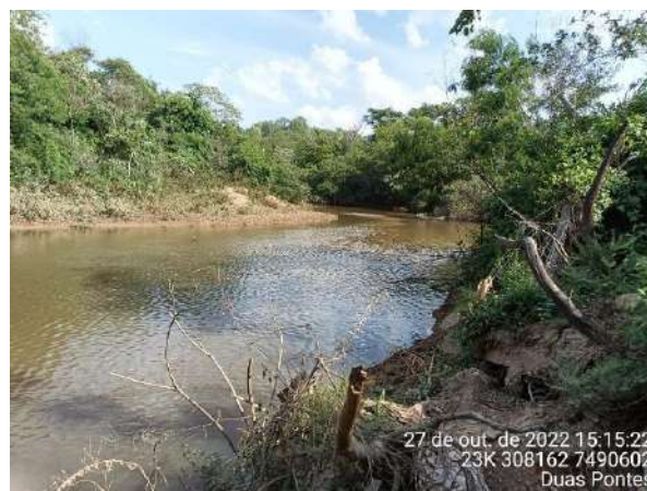
Foto 2 - P02 Rio Camanducaia, no corpo principal do futuro reservatório, próximo à barragem projetada (Data:27/10/2022).
