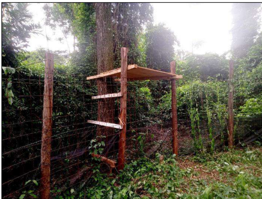
Foto 4.3-7: Estrutura de espera ou observação instalado sobre colunas ou árvores para possibilitar o manejo com segurança aos operadores.
